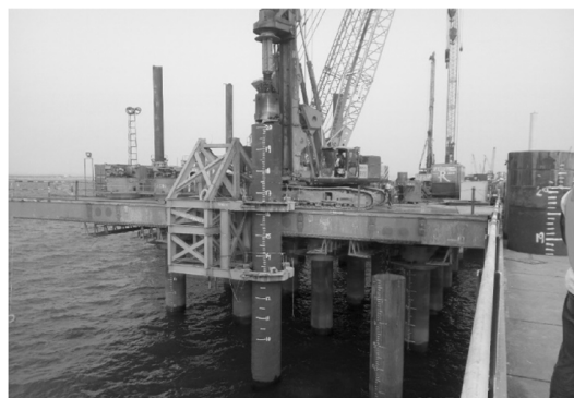
图4 码头桩基钢护筒沉放
