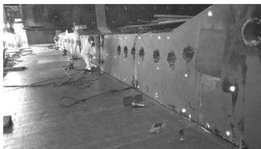
图3 钢帽底板分段焊接及精度调整图
