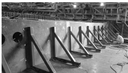
图4 钢帽临时支撑加固
