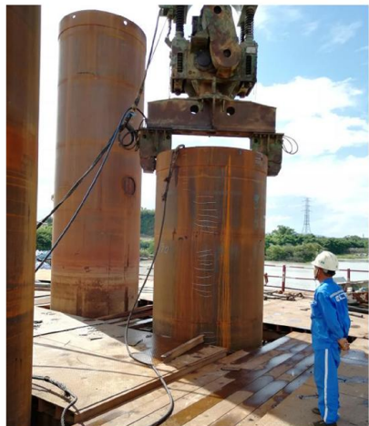
图 4 “气顶法+振动锤”钢护筒拔除工艺现场实施图
