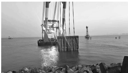
图 4 灌注桩整体吊装拆除图
