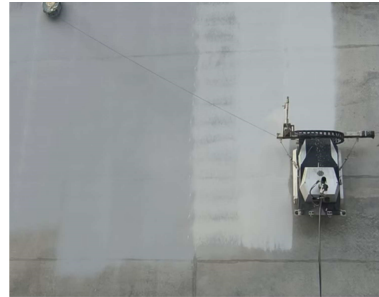
图 5 机器人喷涂作业图示
