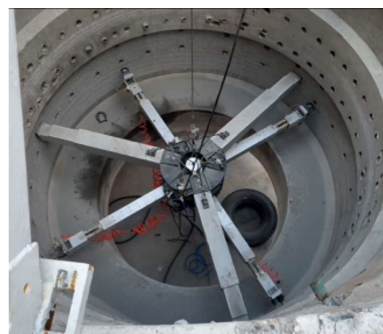
图 2 凿毛机器人后浇孔作业示意图
